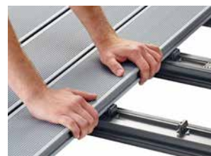
Stecken Sie die Terrassendielen auf den Rahmen
